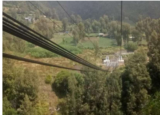
Pengangkuran Wire rope
