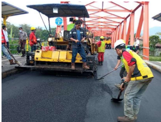
Penghamparan Aspal di Jembatan Geosan
