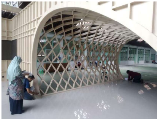
Renovasi Gedung Halil
