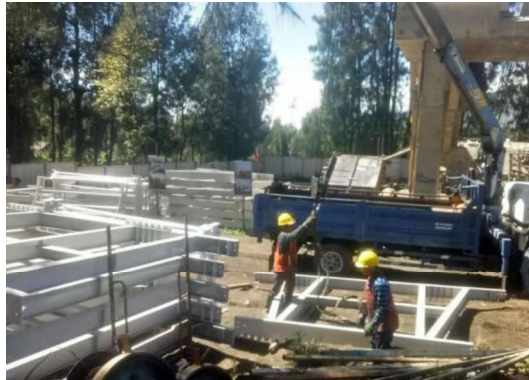
Proses Pengadaan Frame Jembatan
