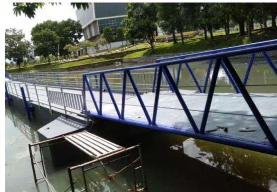
Pemeliharaan Jembatan Apung
