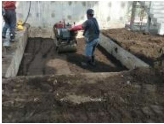
Penimbunan Tanah dari Hasil Galian Shuttle Area
