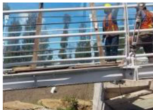
Pemasangan Kaca Laminasi SGP
