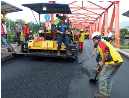
Penghamparan Aspal di Jembatan Geosan
