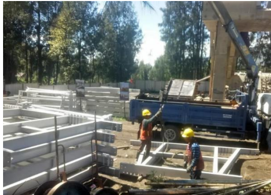
Proses Pengadaan Frame Jembatan
