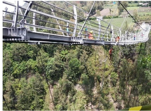
Proses Pekerjaan Penerapan Terbatas Jembatan Pejalan Kaki Struktur Lantai Kaca (Pemasangan Lantai Kaca)
