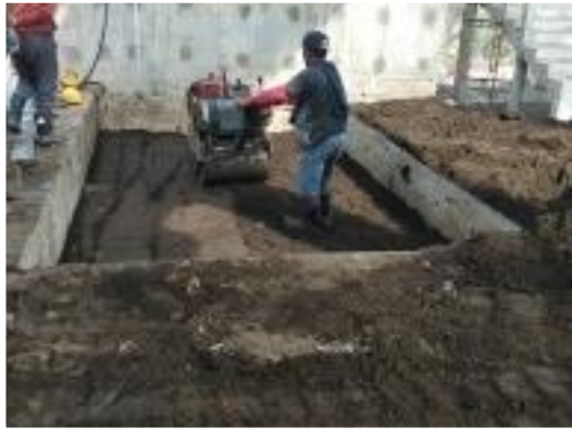
Penimbunan Tanah dari Hasil Galian Shuttle Area
