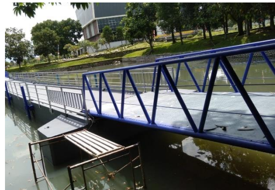
Pemeliharaan Jembatan Apung
