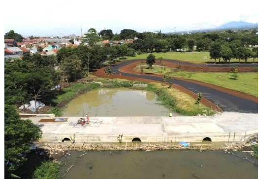
Pekerjaan Pengecoran Mortar Busa pada Kegiatan Penerapan Terbatas Timbunan Ringan
