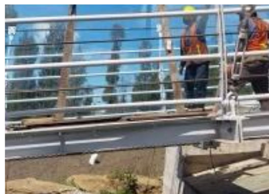
Pemasangan Kaca Laminasi SGP
