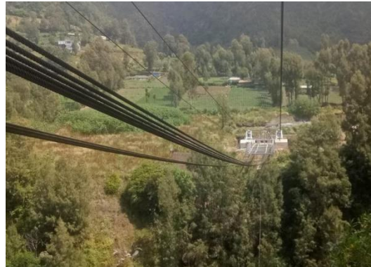
Pengangkuran Wire rope
