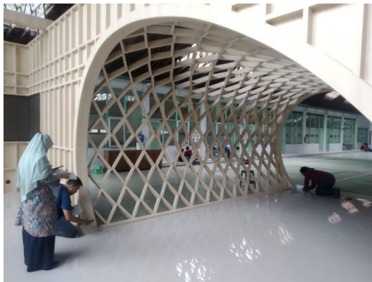
Renovasi Gedung Halil
