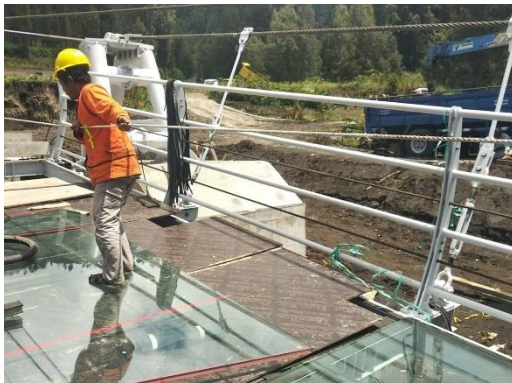
Proses Pekerjaan Penerapan Terbatas Jembatan Pejalan Kaki Struktur Lantai Kaca
