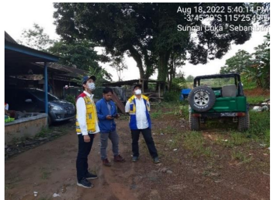
Pendampingan Dalam Rangka Survei Geologi Lokal Pada Ruas Jalan 009 Ds. Sungai Cuka – Sebamban KM BJM 170+900
