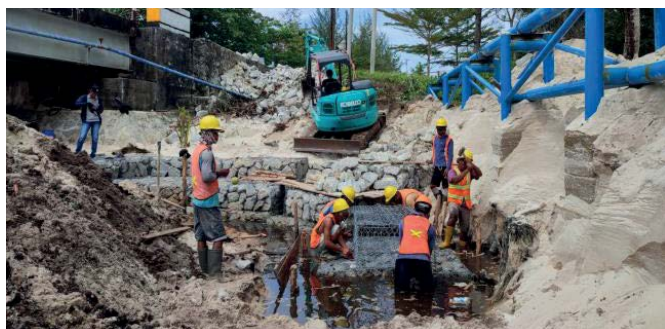
Gambar 8 Kegiatan pasangan batu proteksi abutmen atau bronjong PVC.
