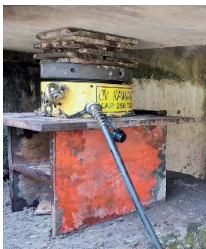
Gambar 4 Kegiatan penggantian landasan elastomer Jembatan Air Rayak dan Jembatan Pilang.
