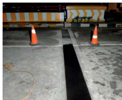
Gambar 3 Kegiatan penggantian siar muai asphaltic plug Jembatan Tambak Udang dan compression seal pilang.
