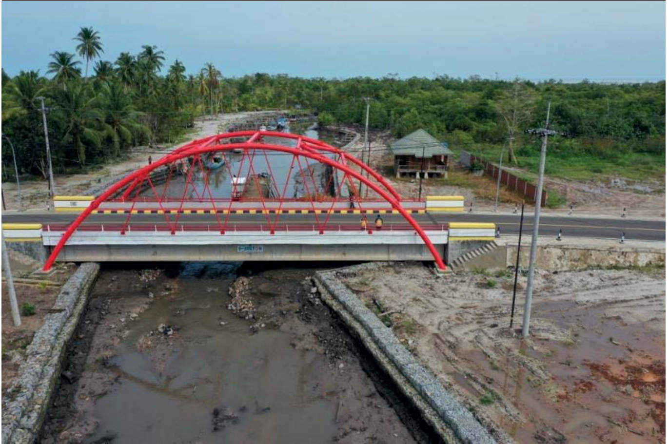
Jembatan Air Terong II.
