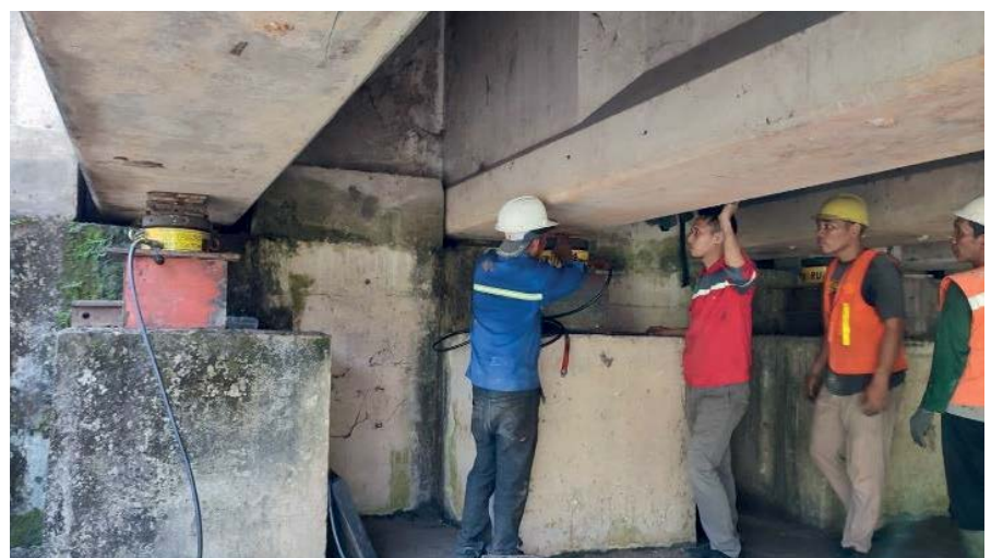
Gambar 4 Kegiatan penggantian landasan elastomer Jembatan Air Rayak dan Jembatan Pilang.
