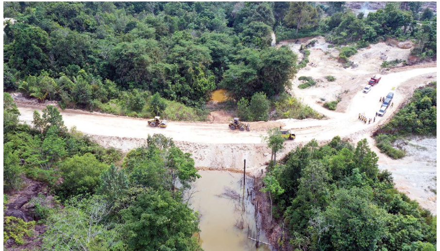
Paket Rehabilitasi Rekonstruksi Jalan Terak - Sp. Bandara.
