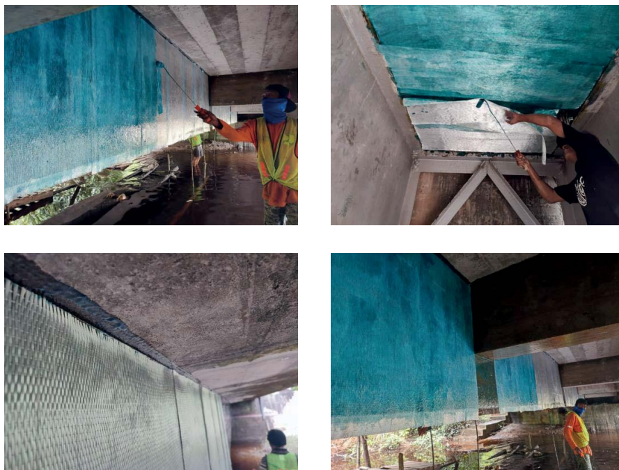
Gambar 7 Kegiatan FRP Jembatan Petikan II, Jembatan Bebulak A.
