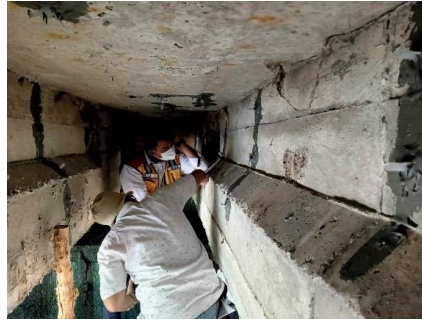
Gambar 5 Kegiatan Injeksi Epoxy Jembatan Petikan II, Jembatan Bebulak B.
