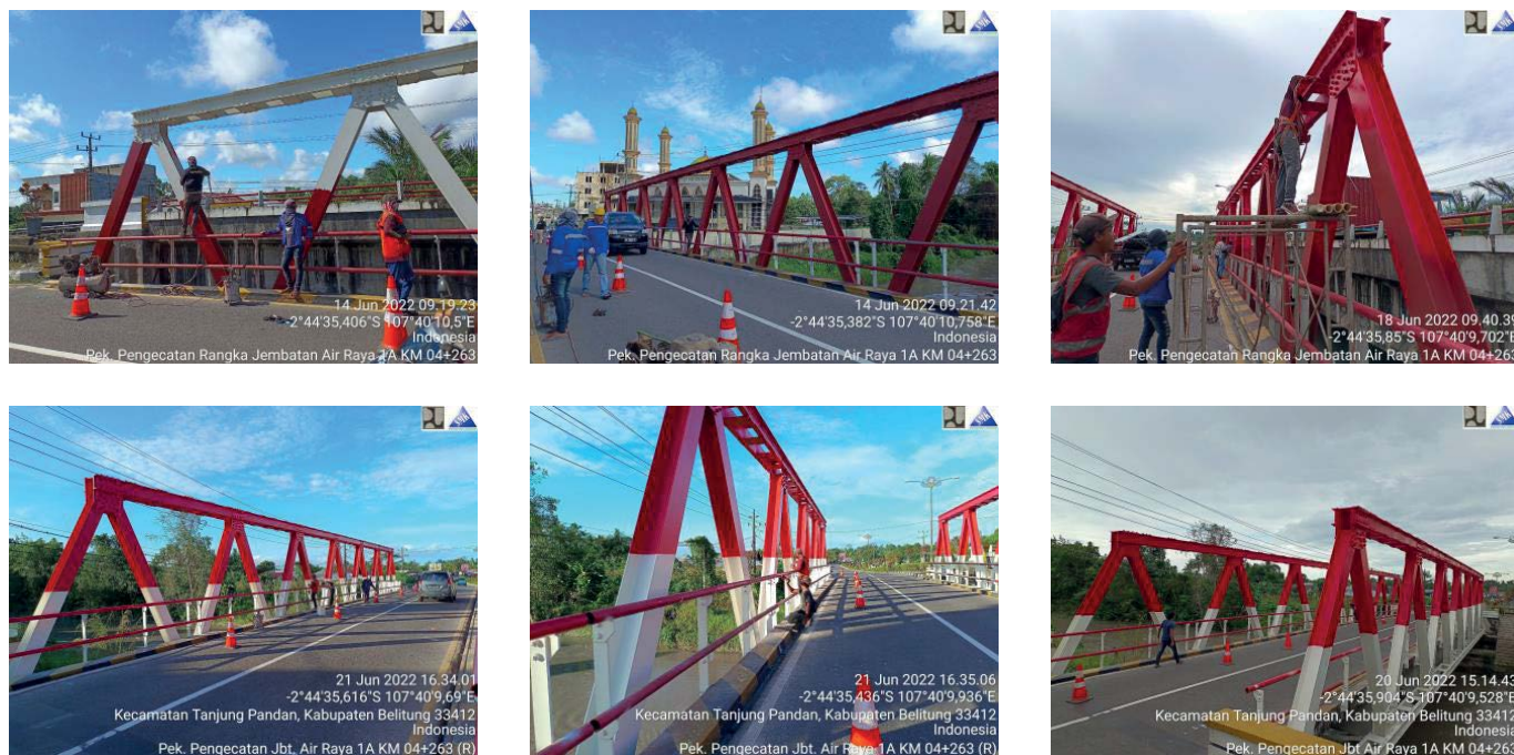
Gambar 2 Kegiatan pengecatan kubu/sijuk dan air rayak baja.
