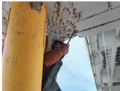
Gambar 5 Kegiatan Injeksi Epoxy Jembatan Petikan II, Jembatan Bebulak B.
