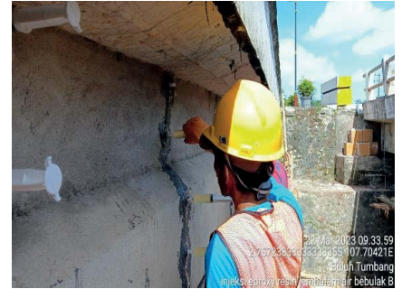
Gambar 5 Kegiatan Injeksi Epoxy Jembatan Petikan II, Jembatan Bebulak B.
