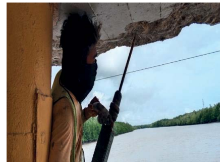
Gambar 5 Kegiatan Injeksi Epoxy Jembatan Petikan II, Jembatan Bebulak B.
