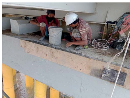
Gambar 6 Kegiatan grouting dan patching di Jembatan Sei Baru I.
