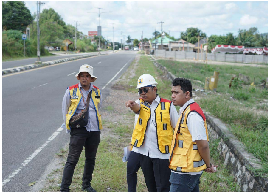
Anggoro Yudho Prasongko bersama dengan Tim dari Satker PJN I Babel dan Satker P2JN Babel meninjau lokasi pekerjaan konstruksi.
